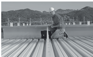
Massaufnahme am Bau (Vorgehen gemäss Seite 7-9)
