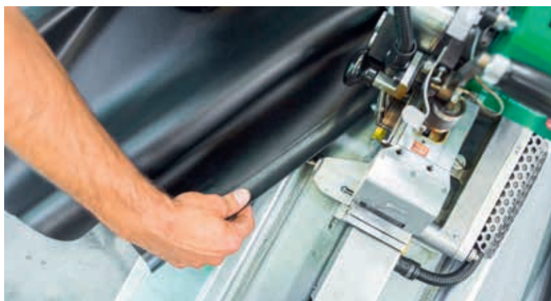
Verschweissen der Abdichtung durch die Thermofast-Fügetechnik.
