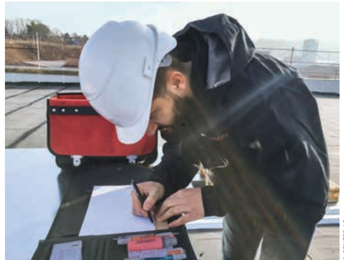
Detaillierte Ausmessung der Dachfläche.
