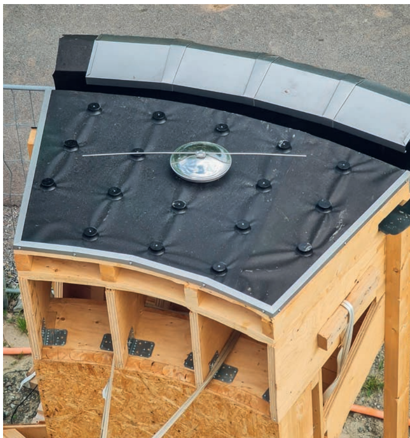
Die Dachkonstruktion vereint moderne Materialien und Holzträger – eine perfekte Symbiose aus Tradition und Innovation.
